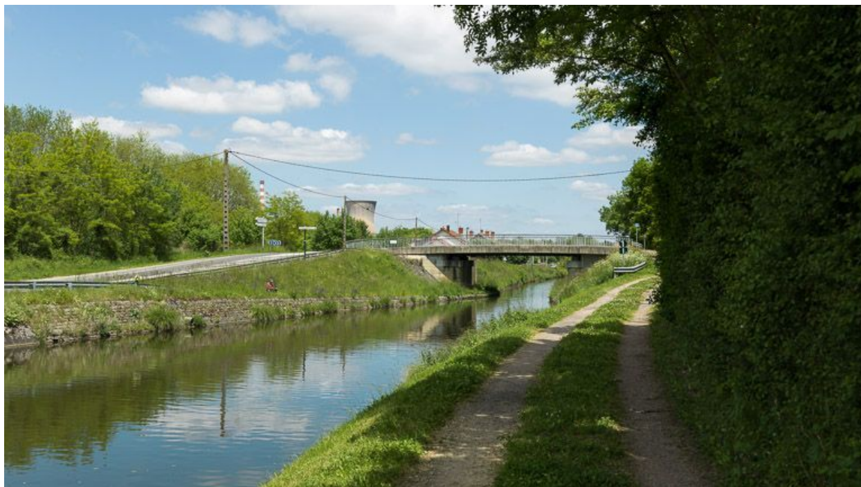
Vue d'ensemble du pont.
