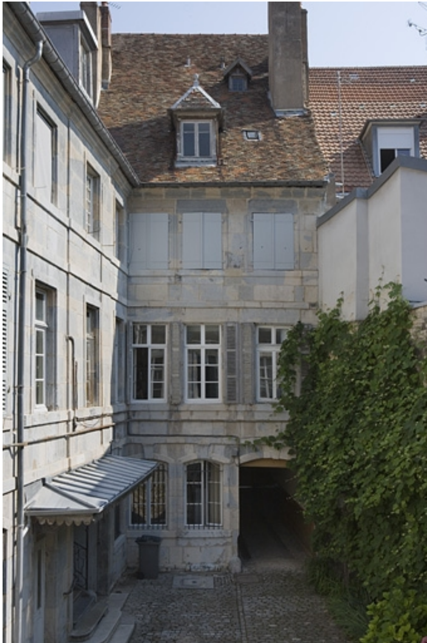
Façade postérieure du logis sur rue et aile sur cour.
