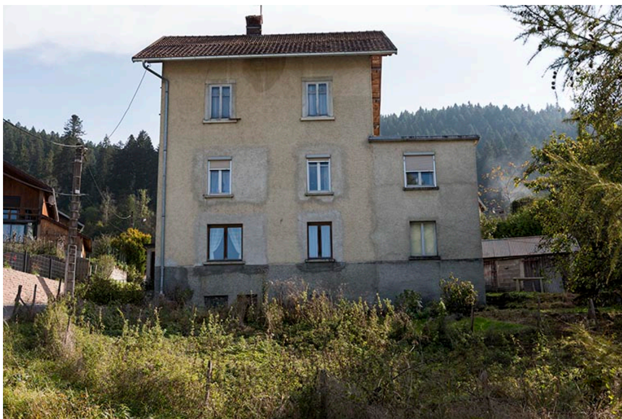
Façade latérale droite, vue en contre-plongée.
