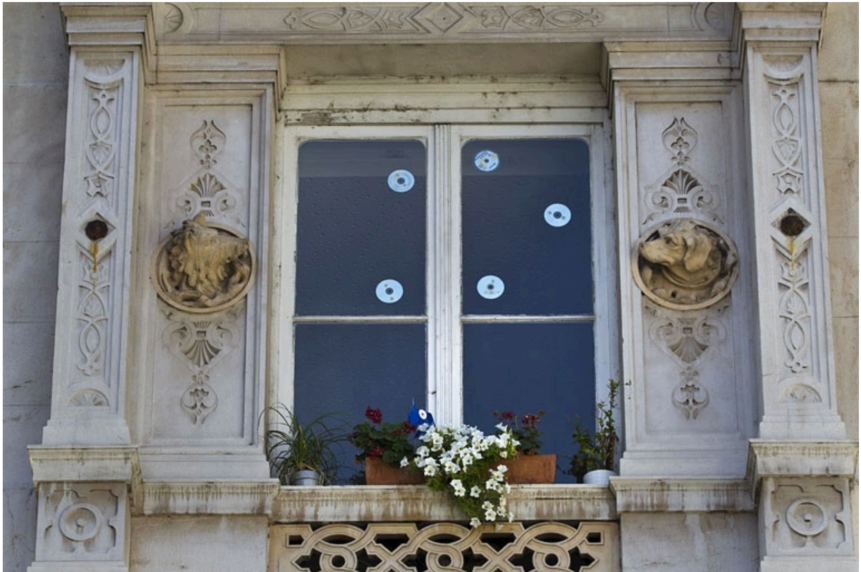
Façade d'angle, deuxième étage, baie centrale : vue d'ensemble.
