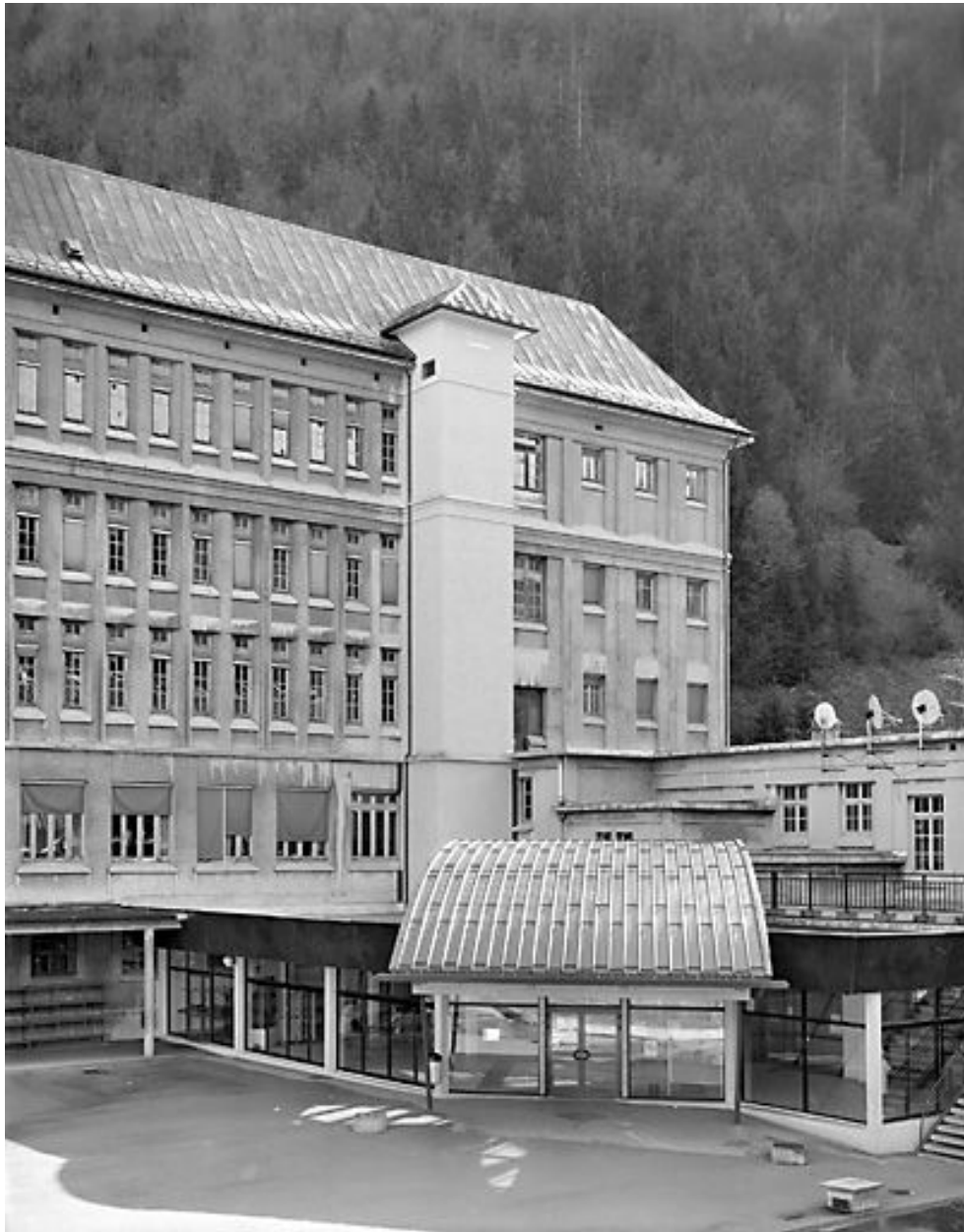
Bâtiment D (extrémité sud de la façade sur la cour) et cafétéria, avant restauration.
