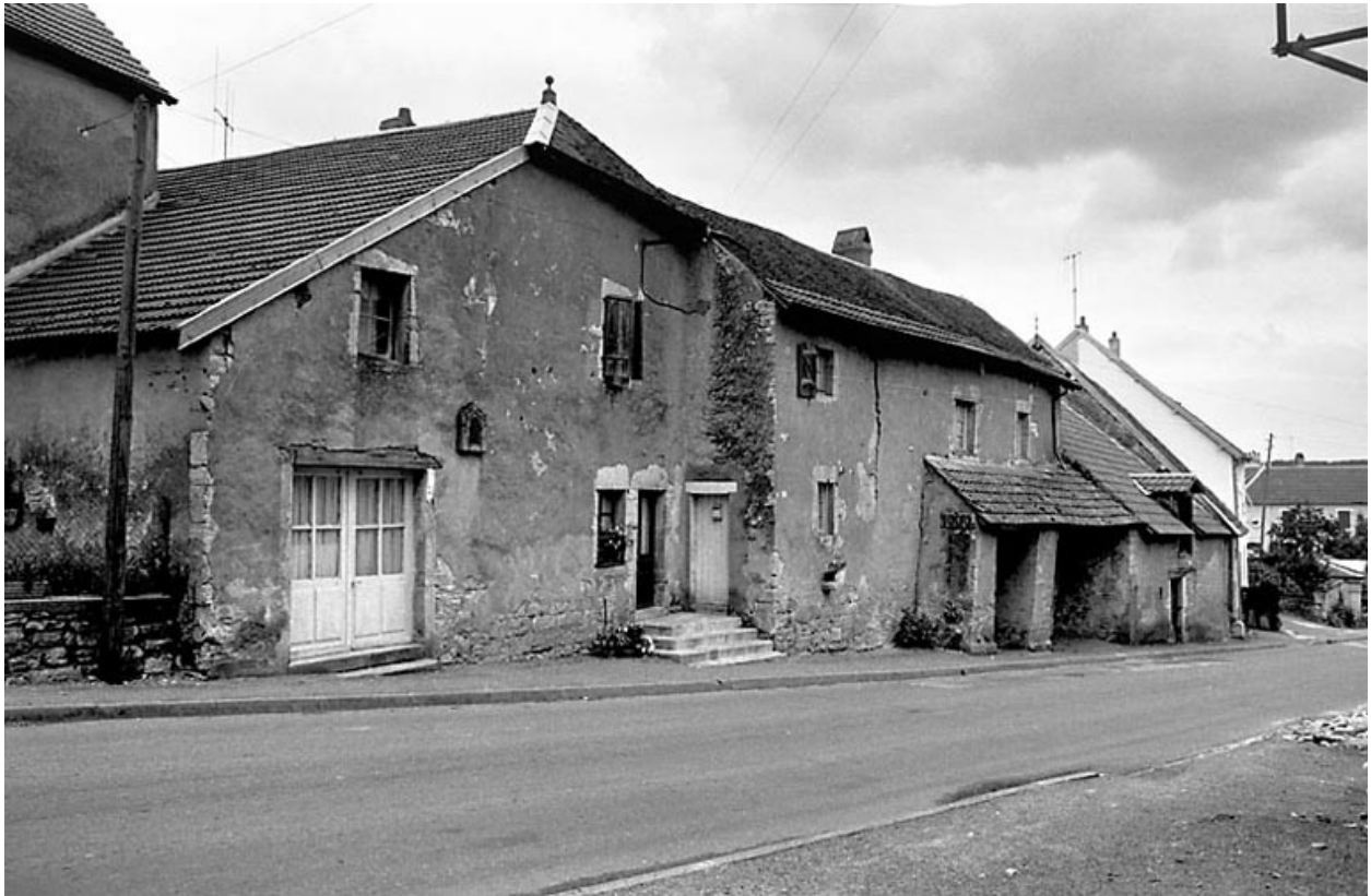
Ferme située rue Principale.
