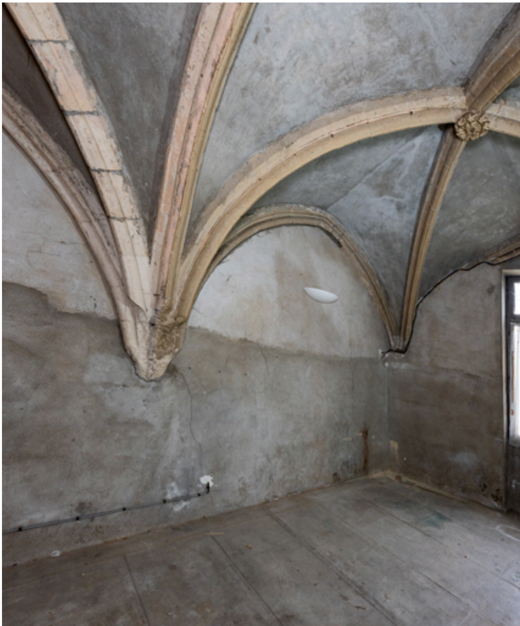
Salle du sous-sol couverte de croisées d'ogives.
