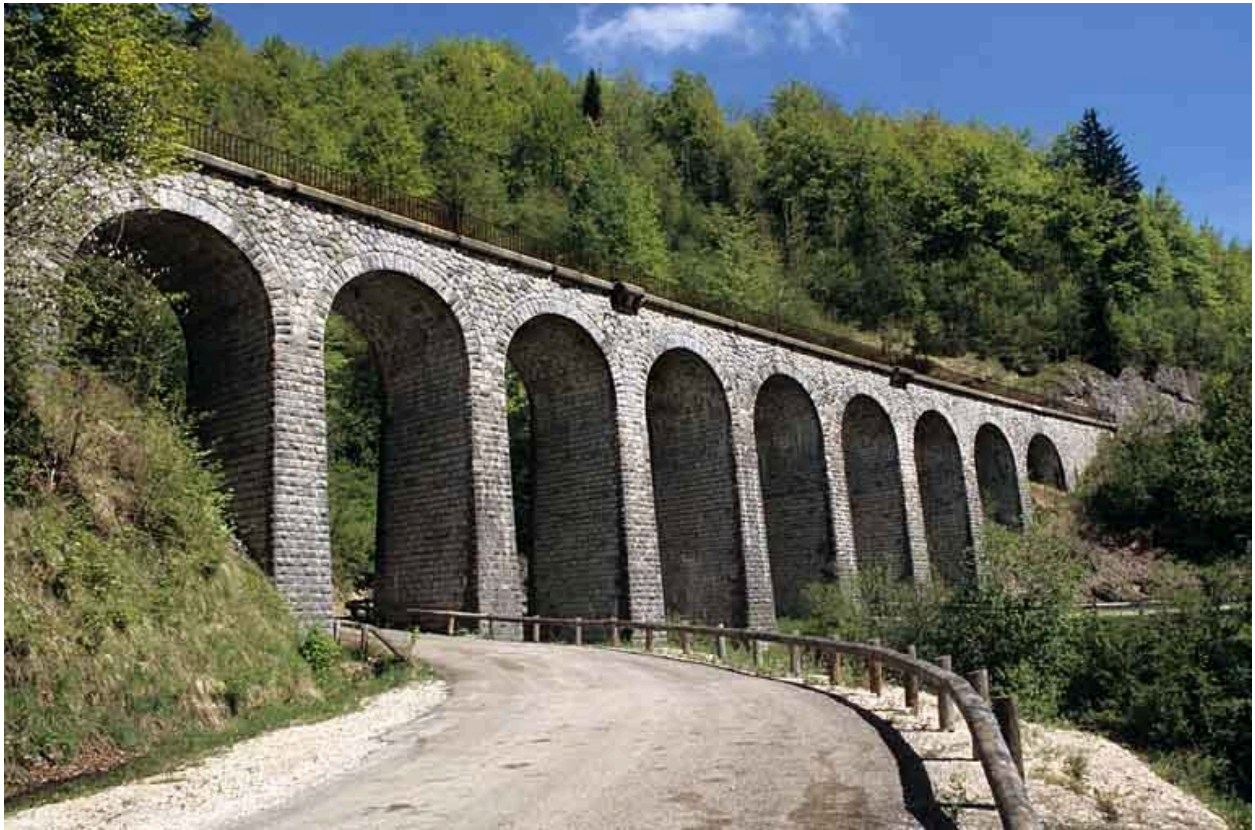
Viaduc du Puits : élévation aval (sud-est), de trois quarts gauche.
