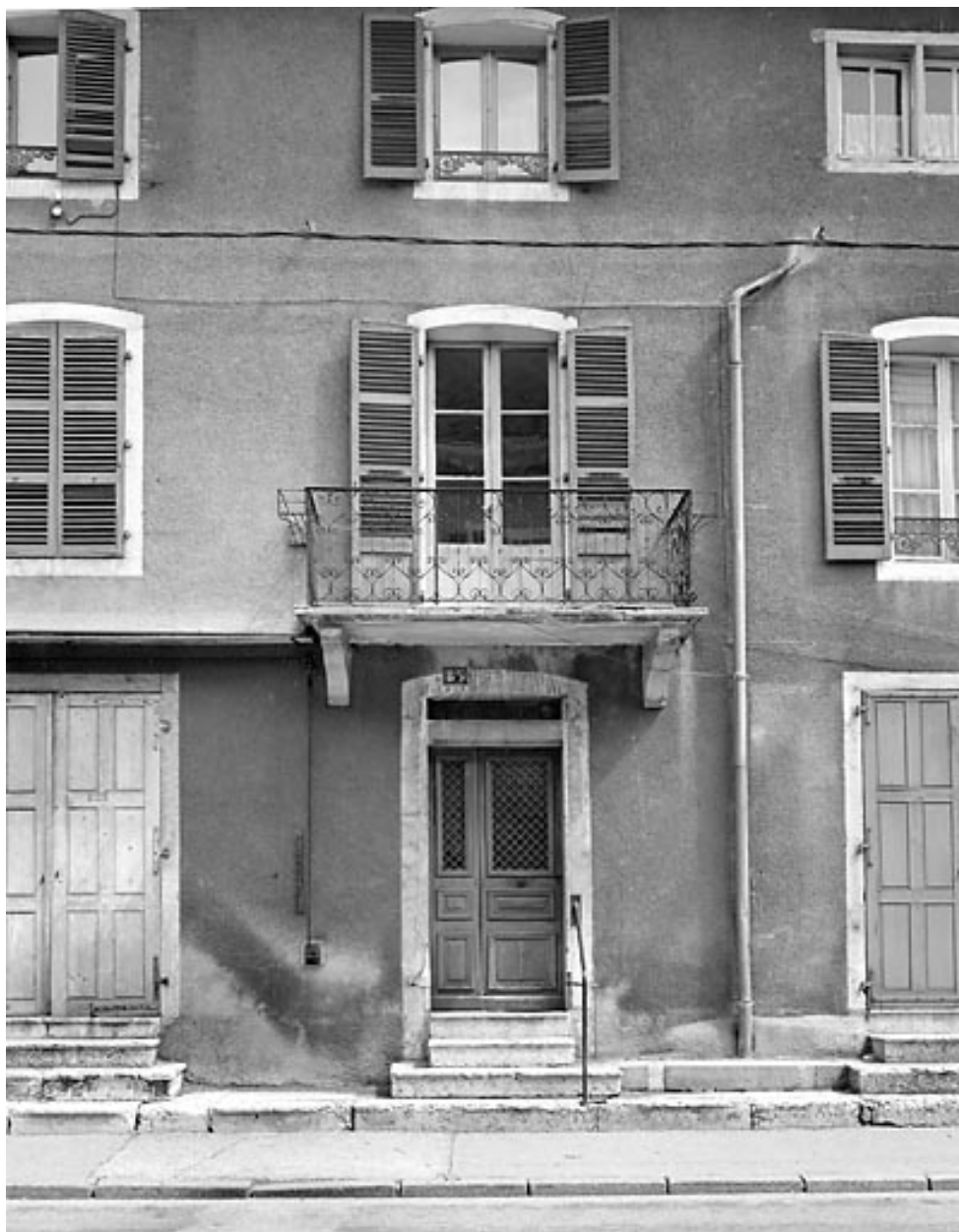
Façade antérieure : travée centrale.
