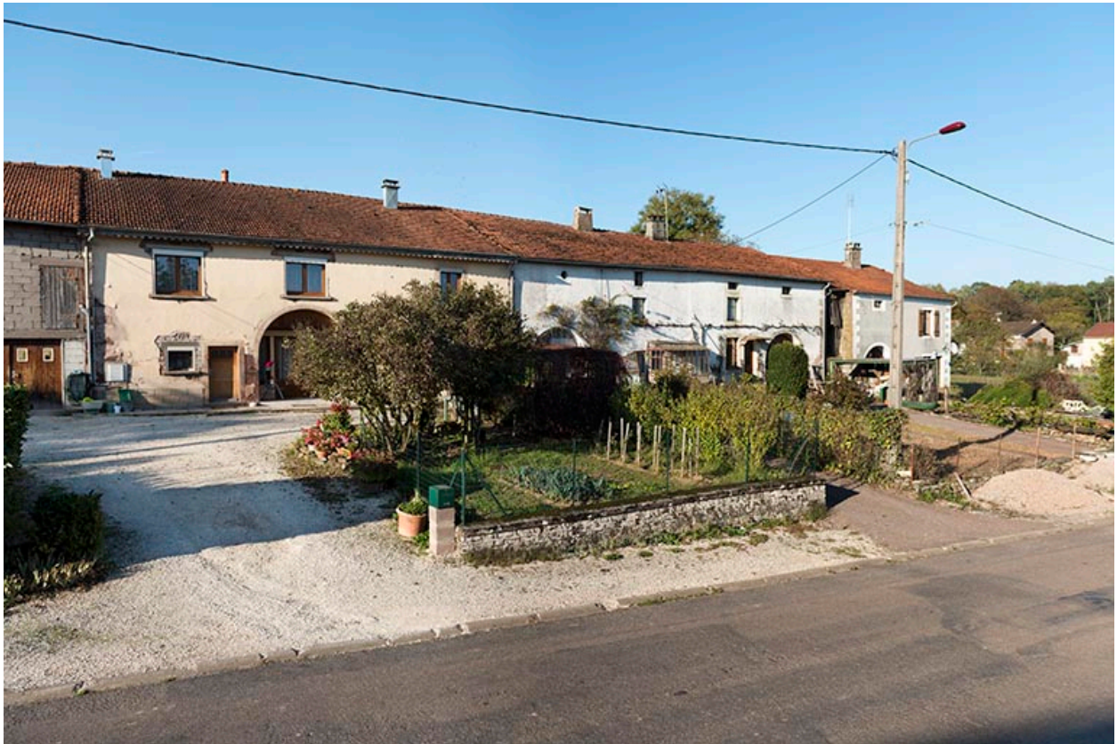
Alignement de fermes, Grande rue.
