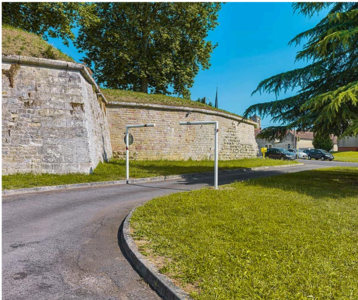
Vestige de l'ancienne tour du "Béchet".
