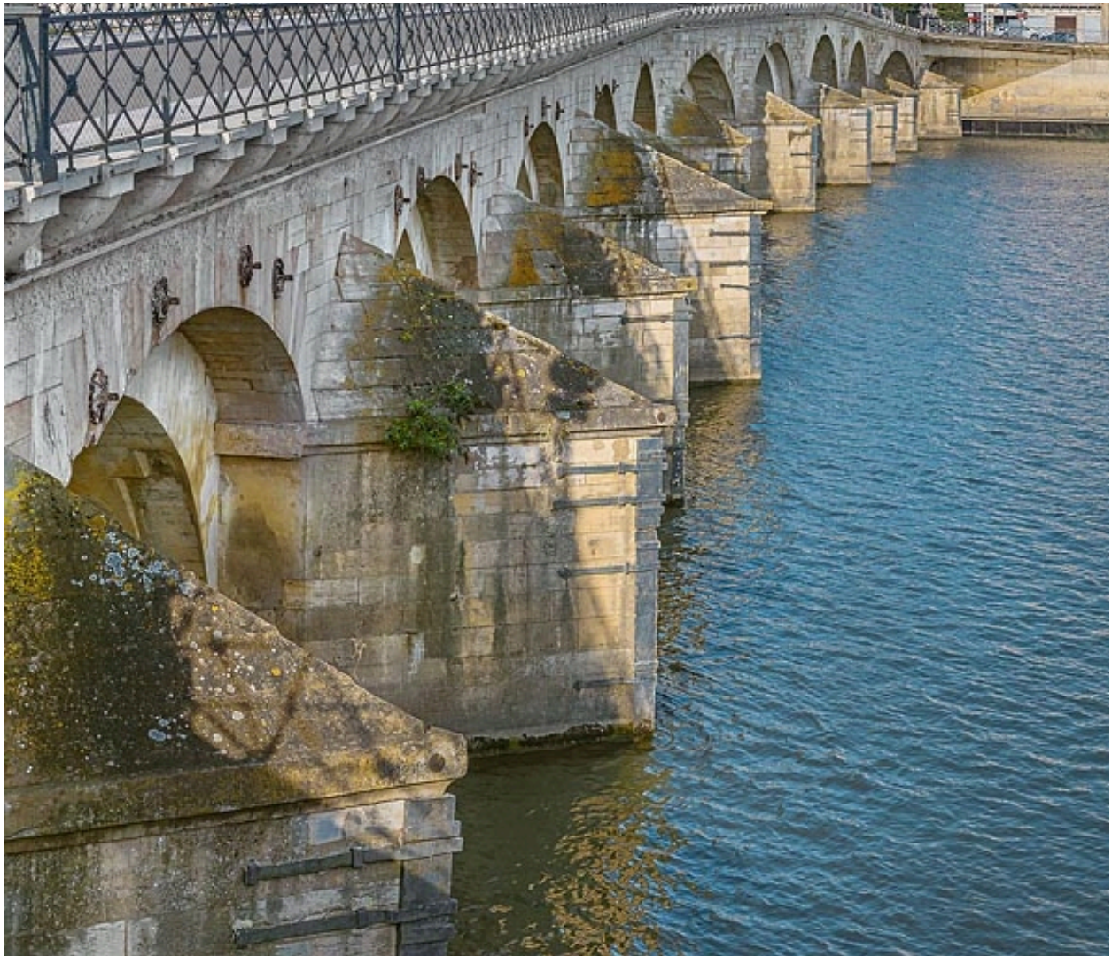
Les avant-becs du pont Saint-Laurent.
