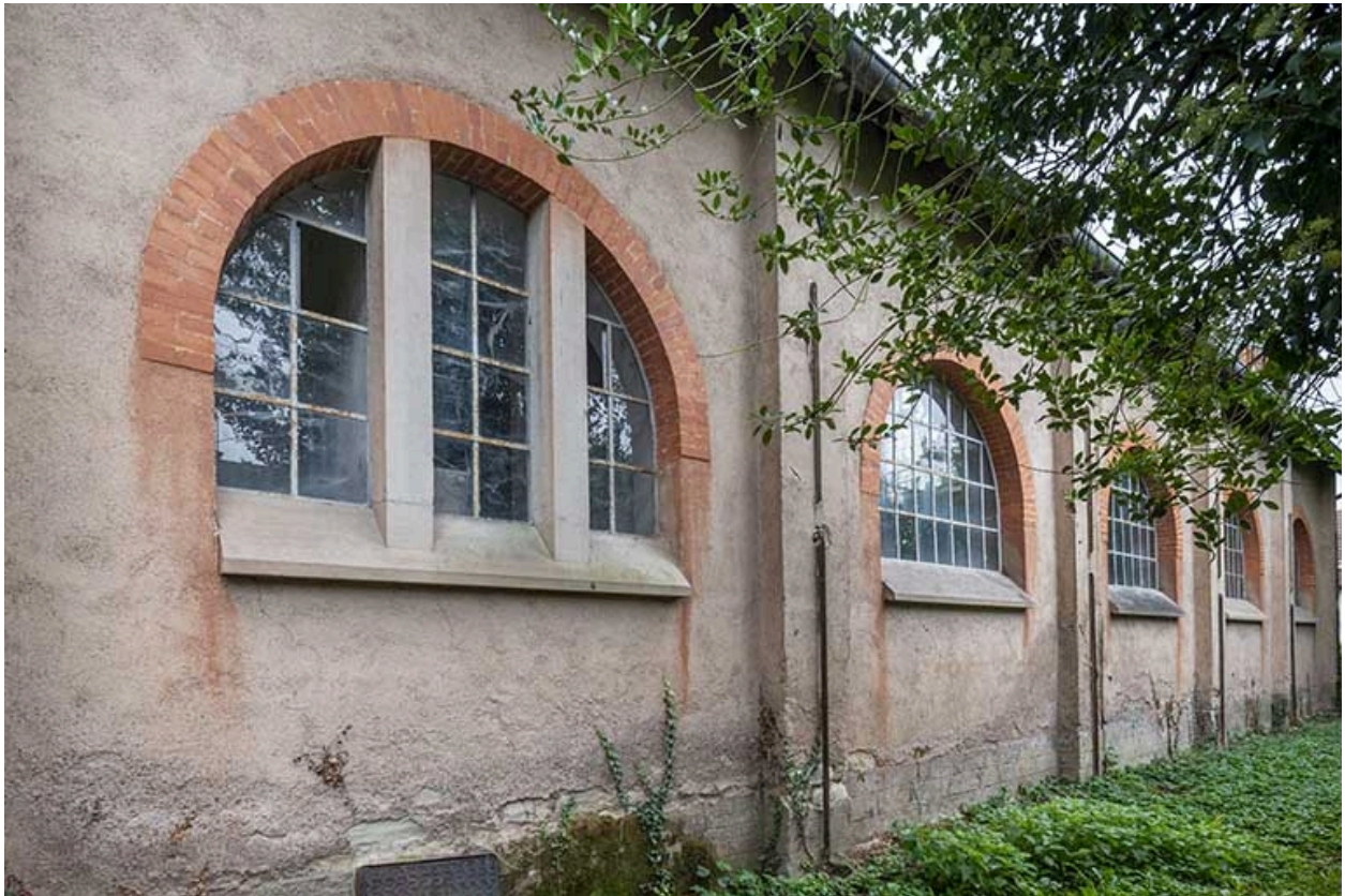
Mur-guttereau ouest, fenêtre thermale.
