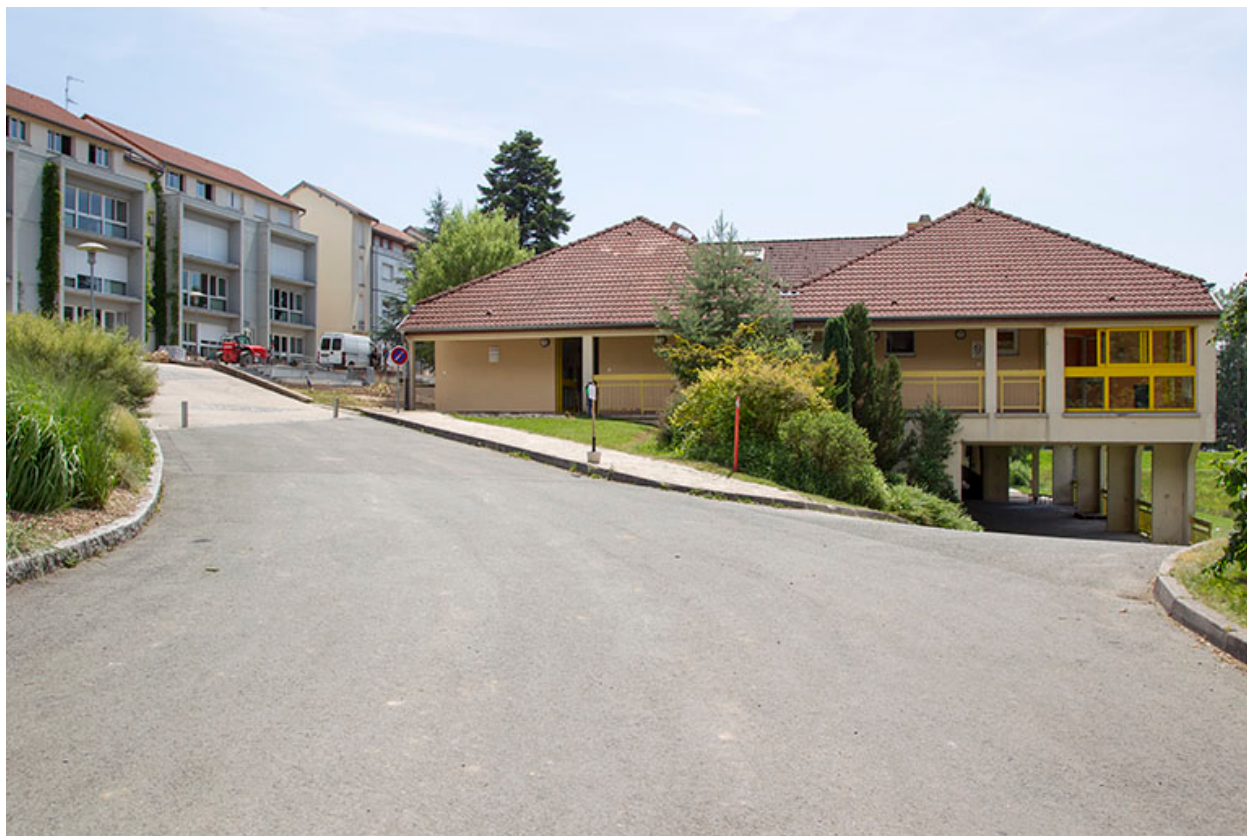
Façade nord de la restauration.
