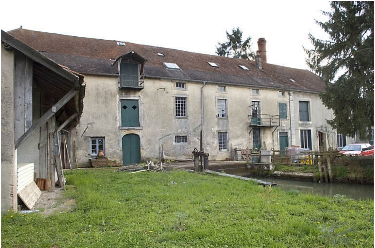
Façade antérieure depuis le nord-ouest.
