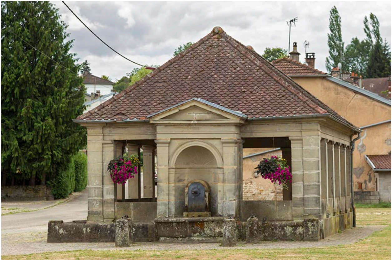
Fontaine-lavoir de la rue Charrière de Vouécourt.
