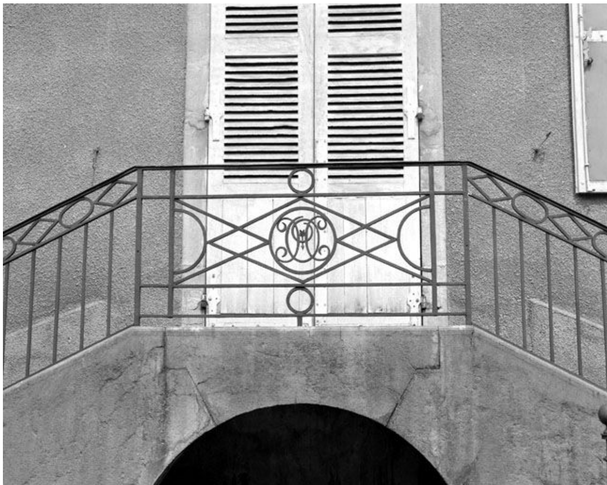
Façade antérieure du logis : détail du perron.
