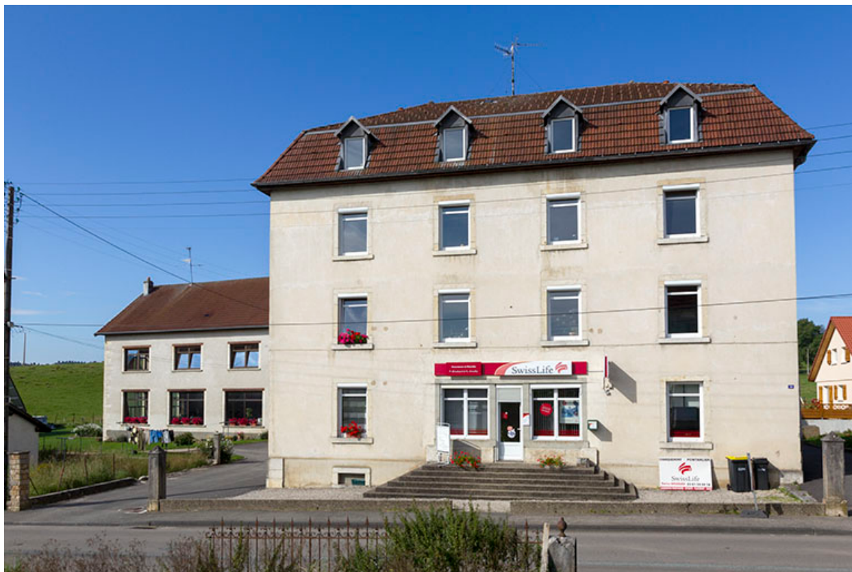
Logement patronal : façade antérieure.
