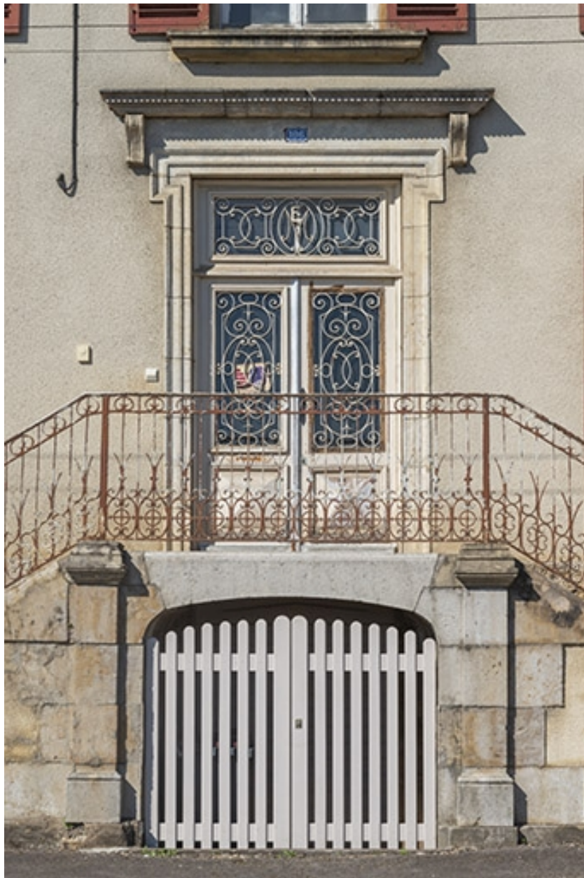
Rue Thiers, entrées de sous-sol et du rez-de-chaussée surélevé de la demeure n° 106.
