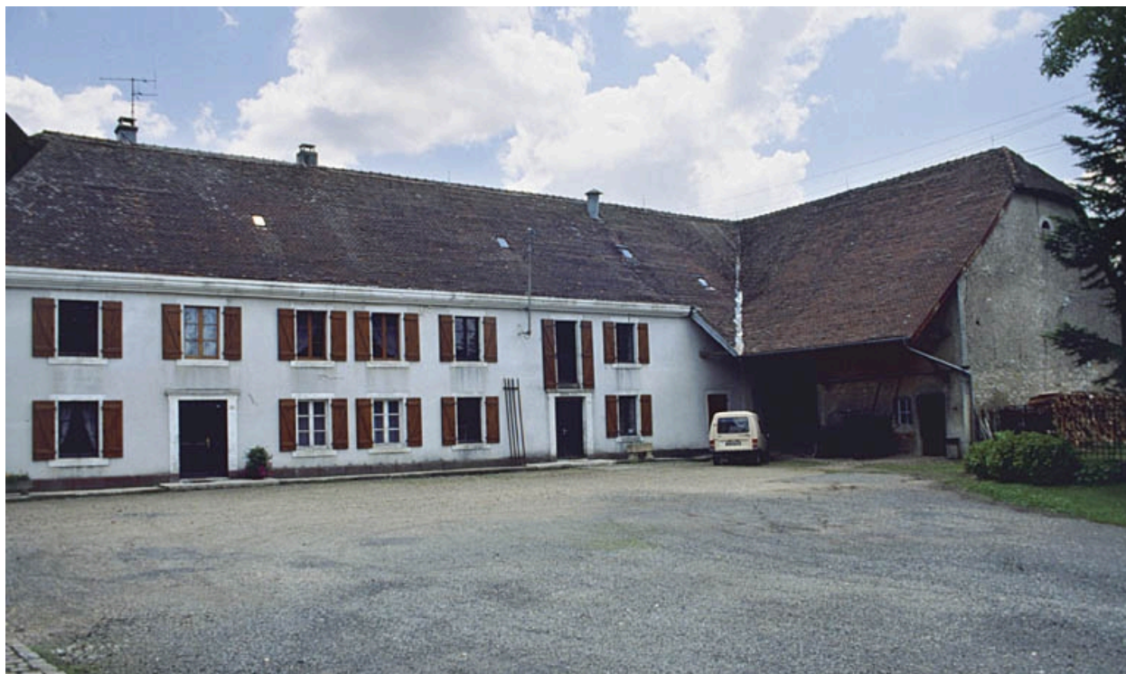
Façade antérieure. De gauche à droite : logement, moulin et parties agricoles.
