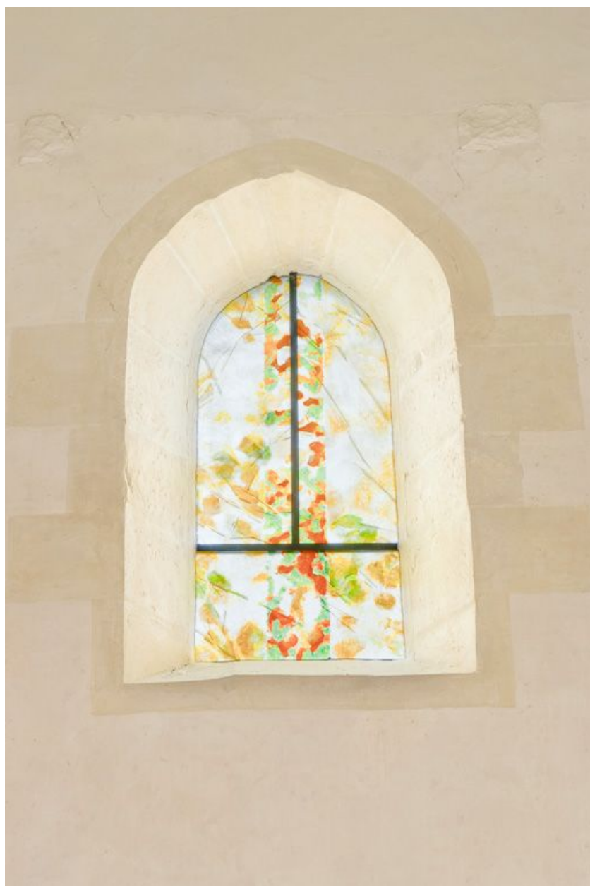
Baie et vitrail de la façade.
