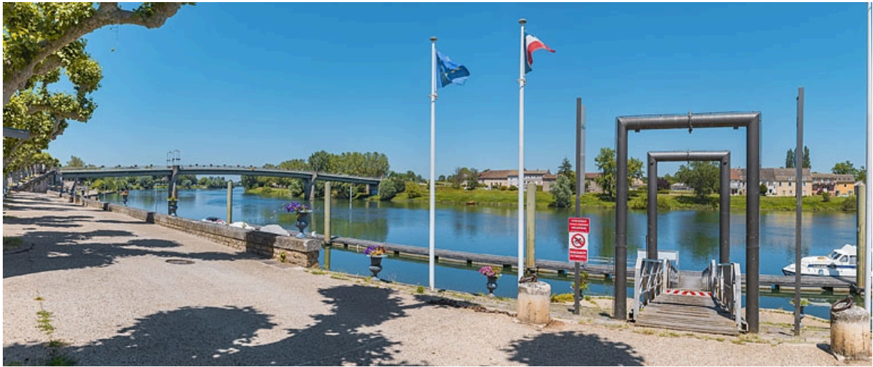
Passerelle donnant accès aux pontons en rivière, au milieu des quais à gradins.
