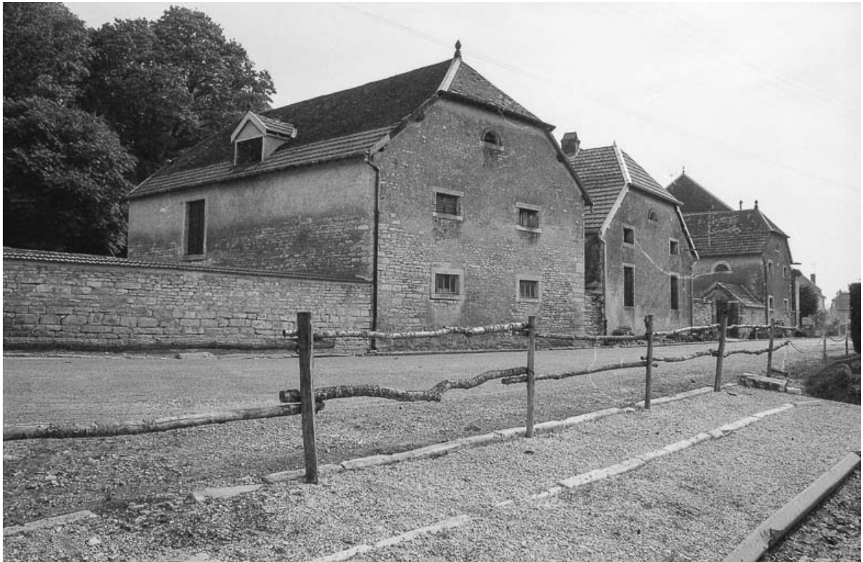
Façades sur rue.
