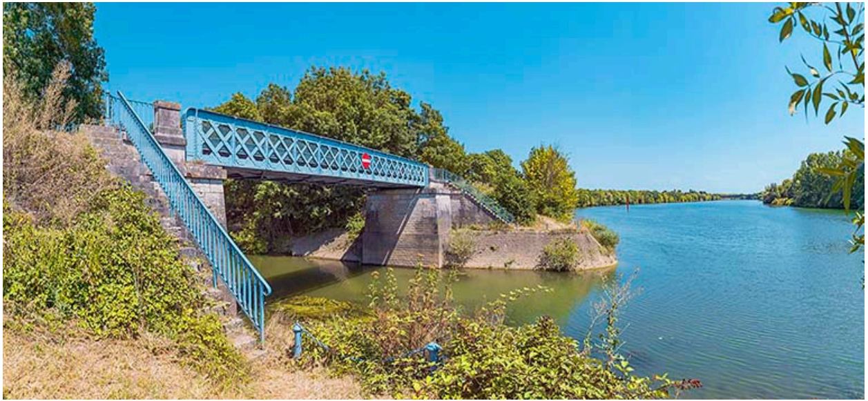
Vue d'ensemble du pont sur la Dheune.
