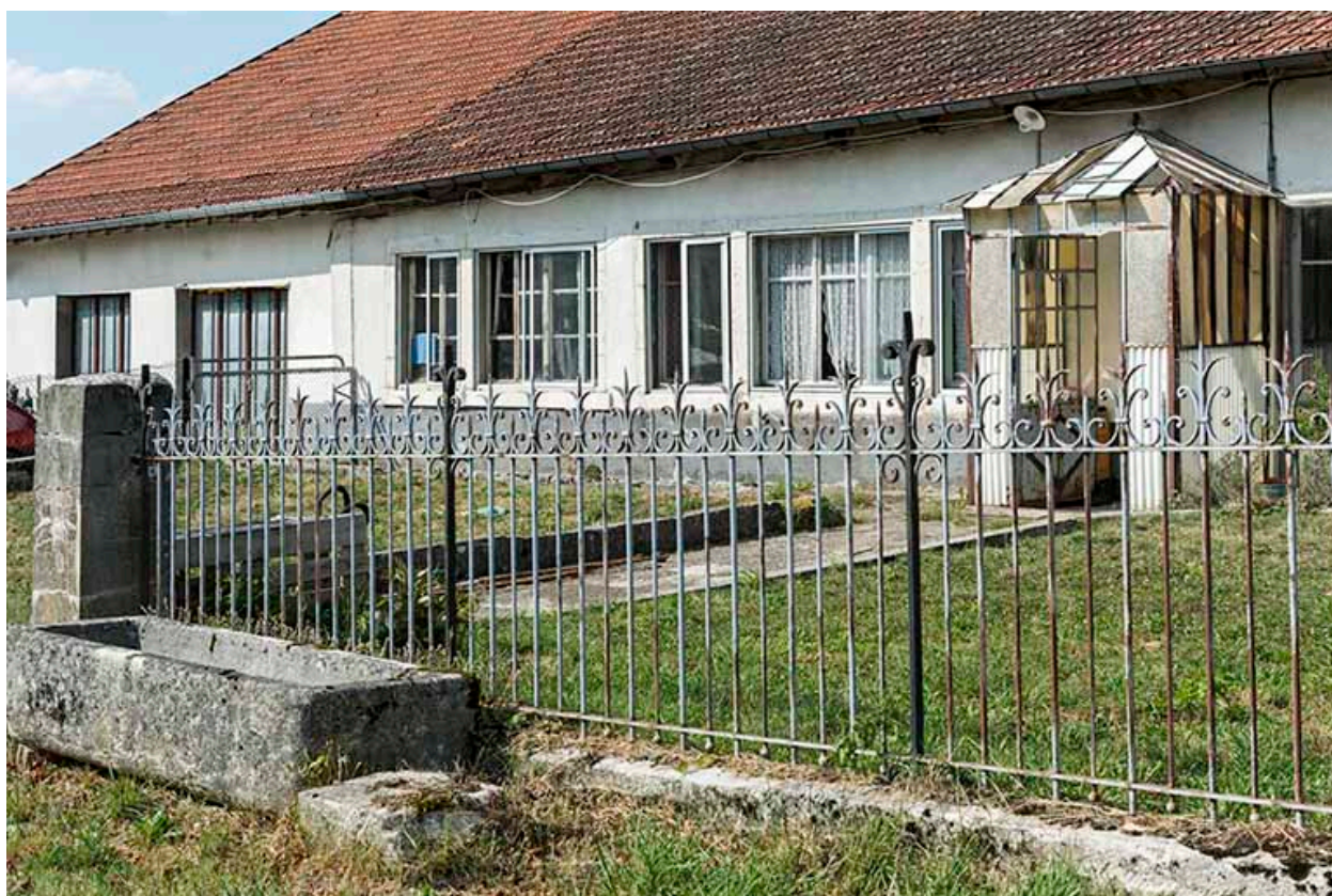
Fenêtres de l'atelier sur la façade antérieure.
