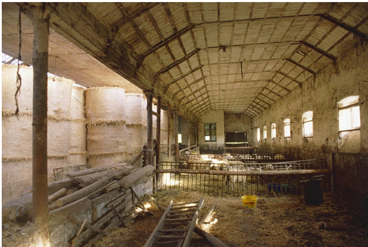
Travée sud de l'étable.
