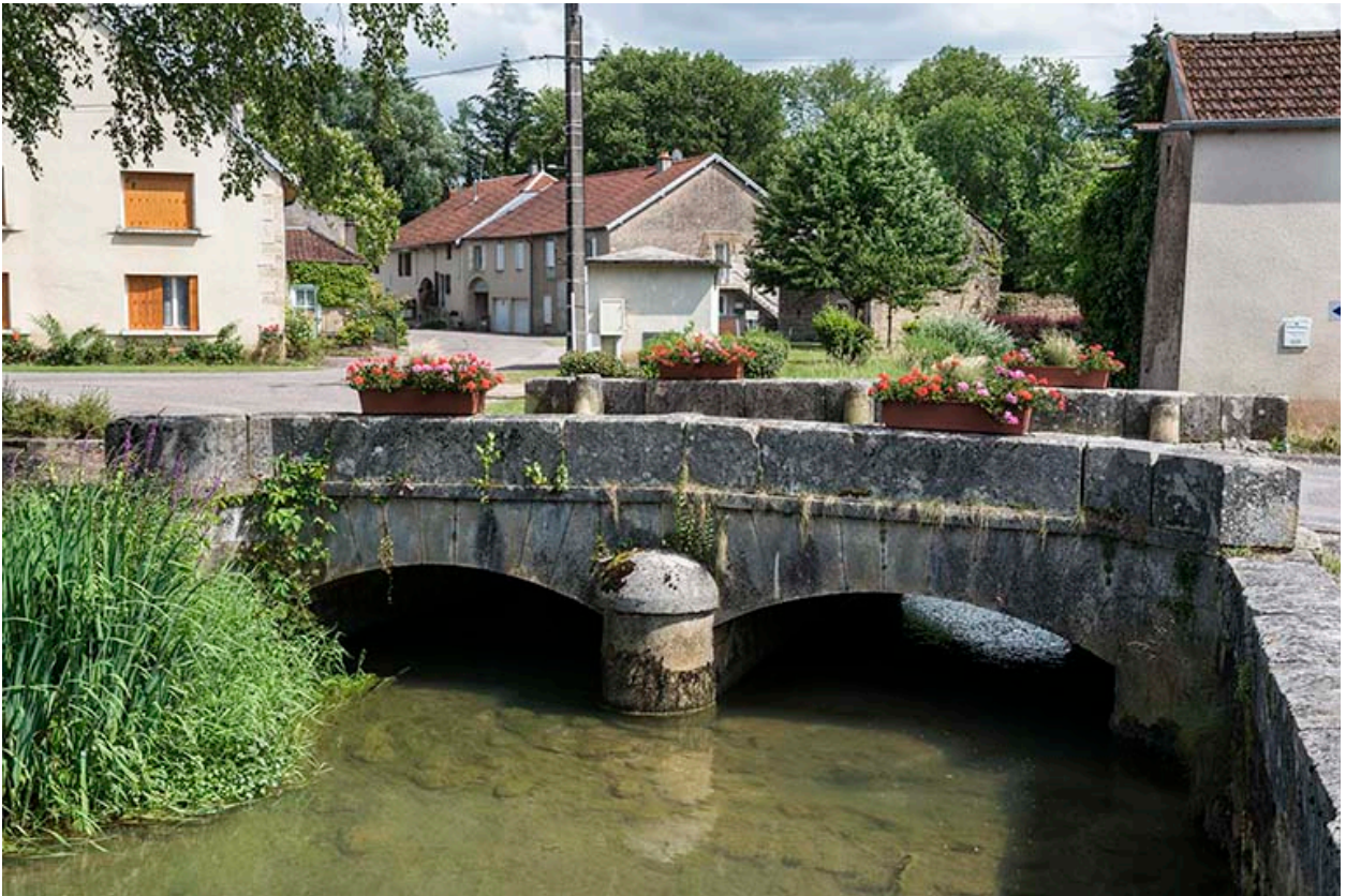
Face nord, vue depuis le nord.
