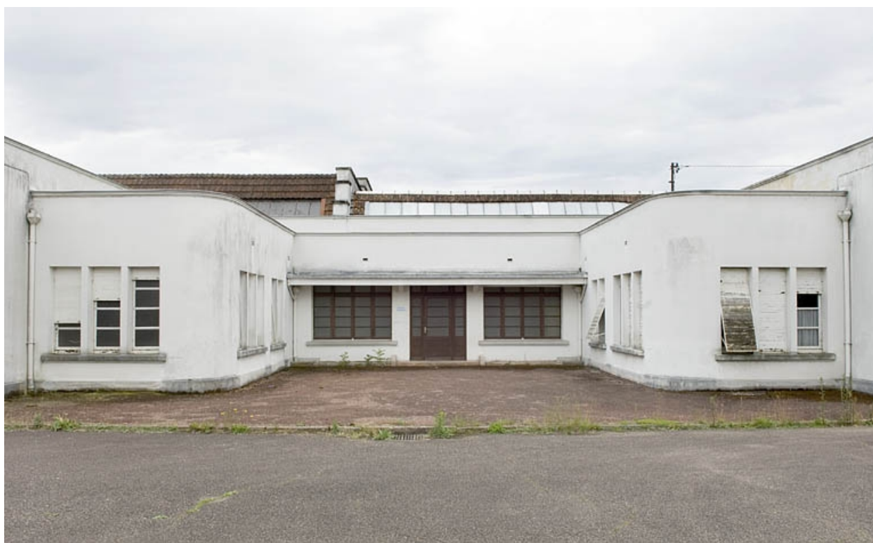
Les bureaux. Vue de face.
