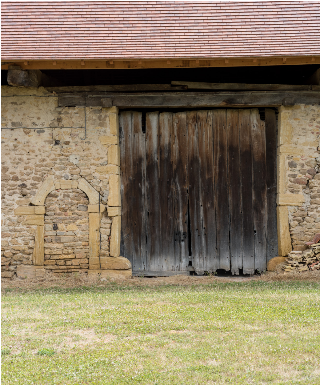
Détail de la façade antérieure de la grange : porte charretière de la remise, au centre de la façade, et ancienne porte piétonnière bouchée
