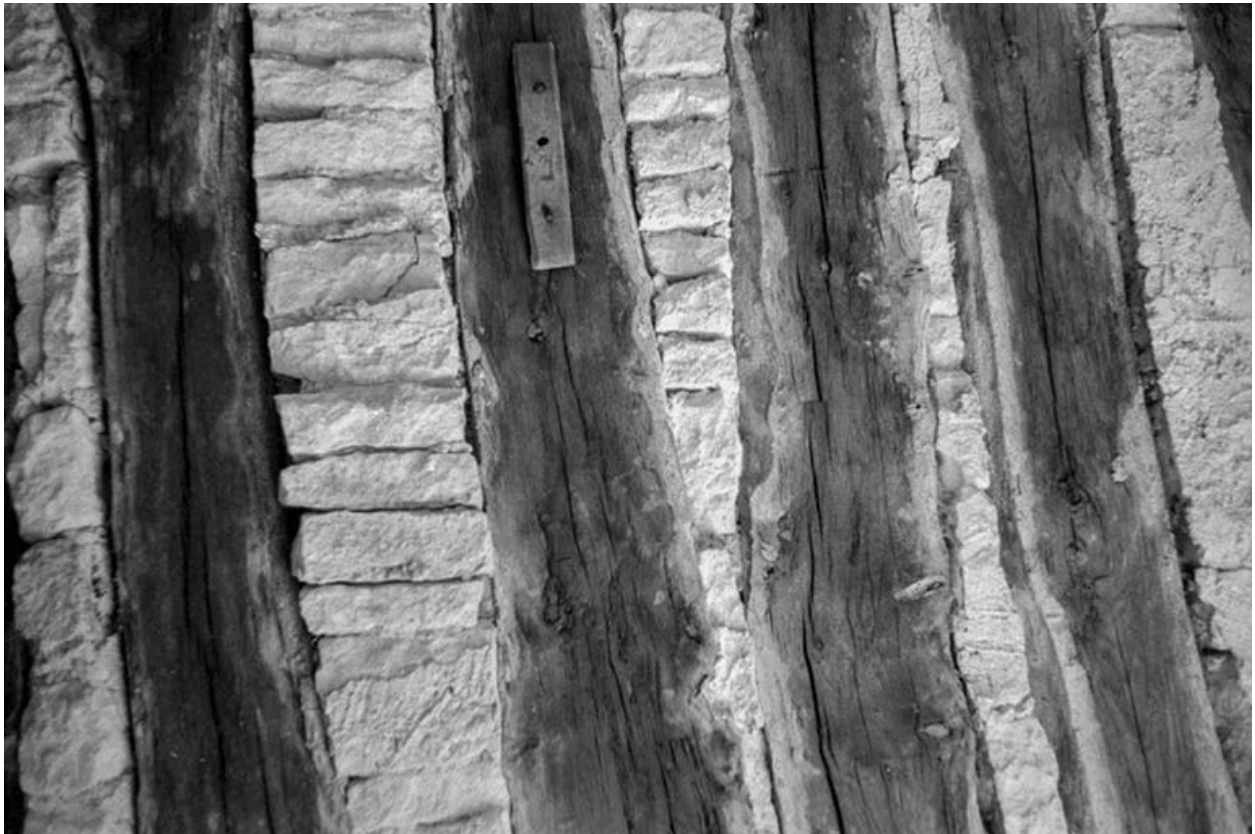
Intérieur des parties agricoles : le plafond.
