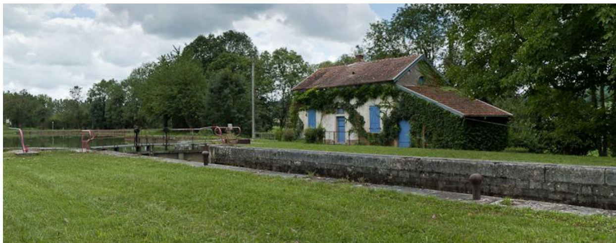
Vue d'ensemble du site d'écluse.
