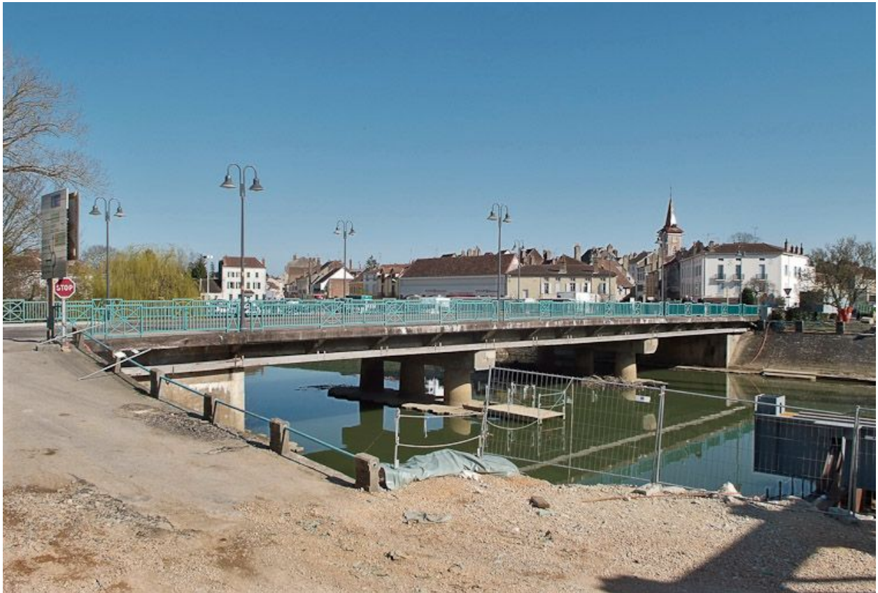
Pont routier sur la Seille, vue d'aval.
