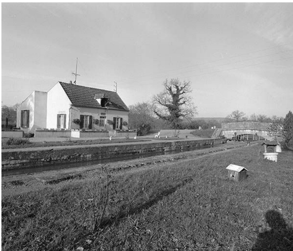
Vue d'ensemble prise de l'amont.
