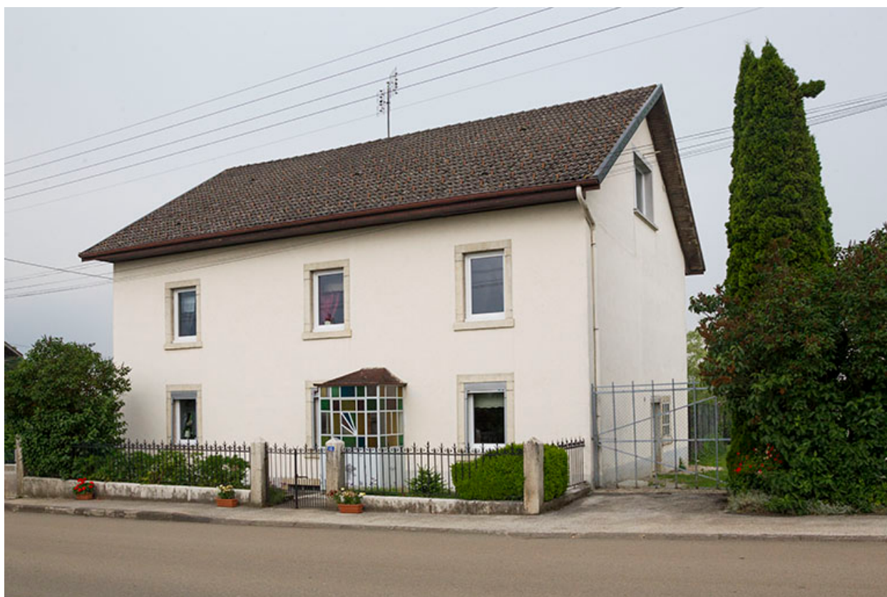
Maison au 12 Grande Rue : façade antérieure.
