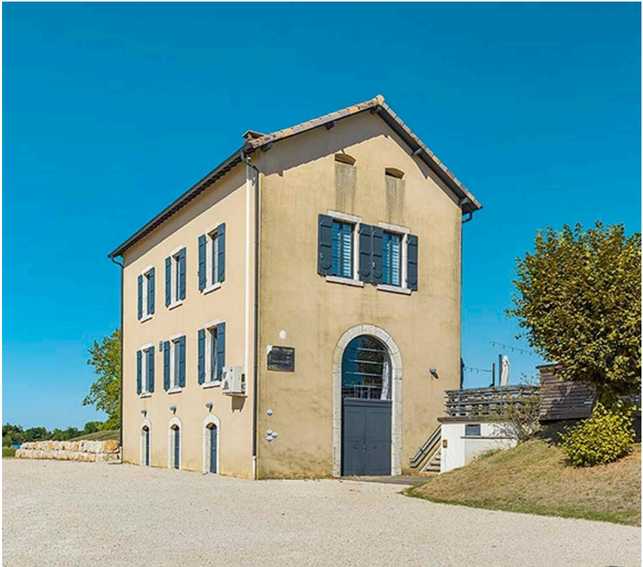
Pignon et façade postérieure de la maison.
