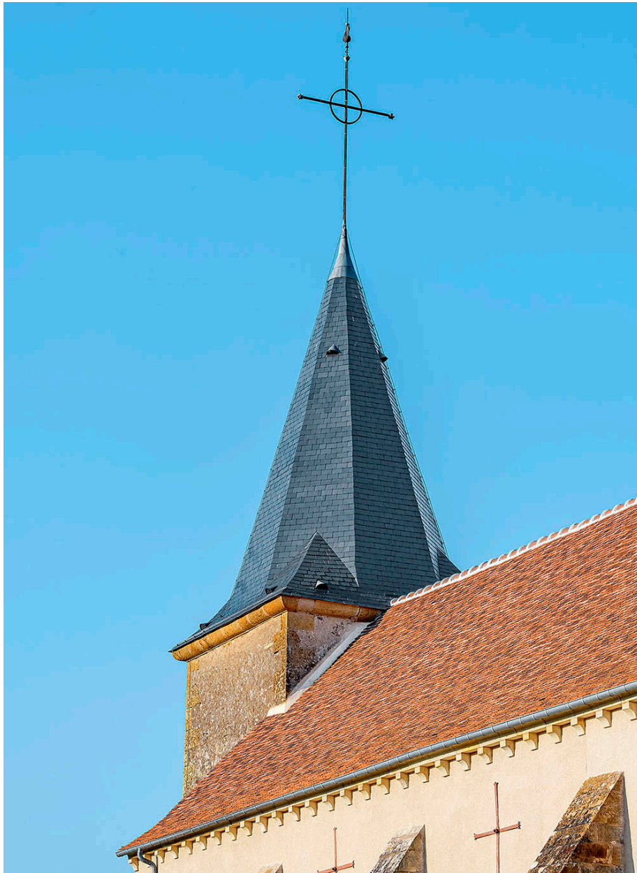
Détail de la couverture en tuiles plates restaurée et du clocher.
