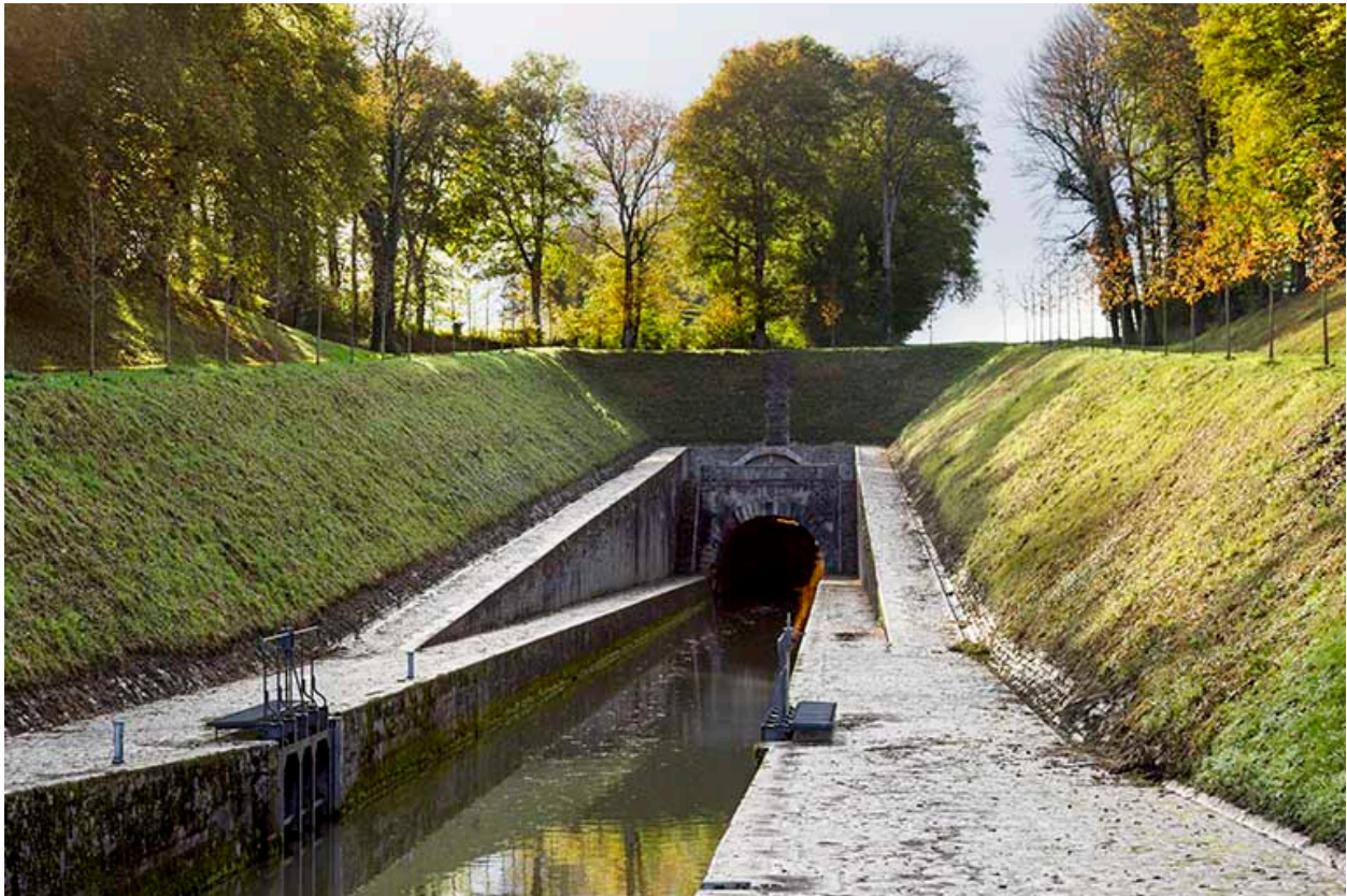
Le canal et le tunnel, vue amont.
