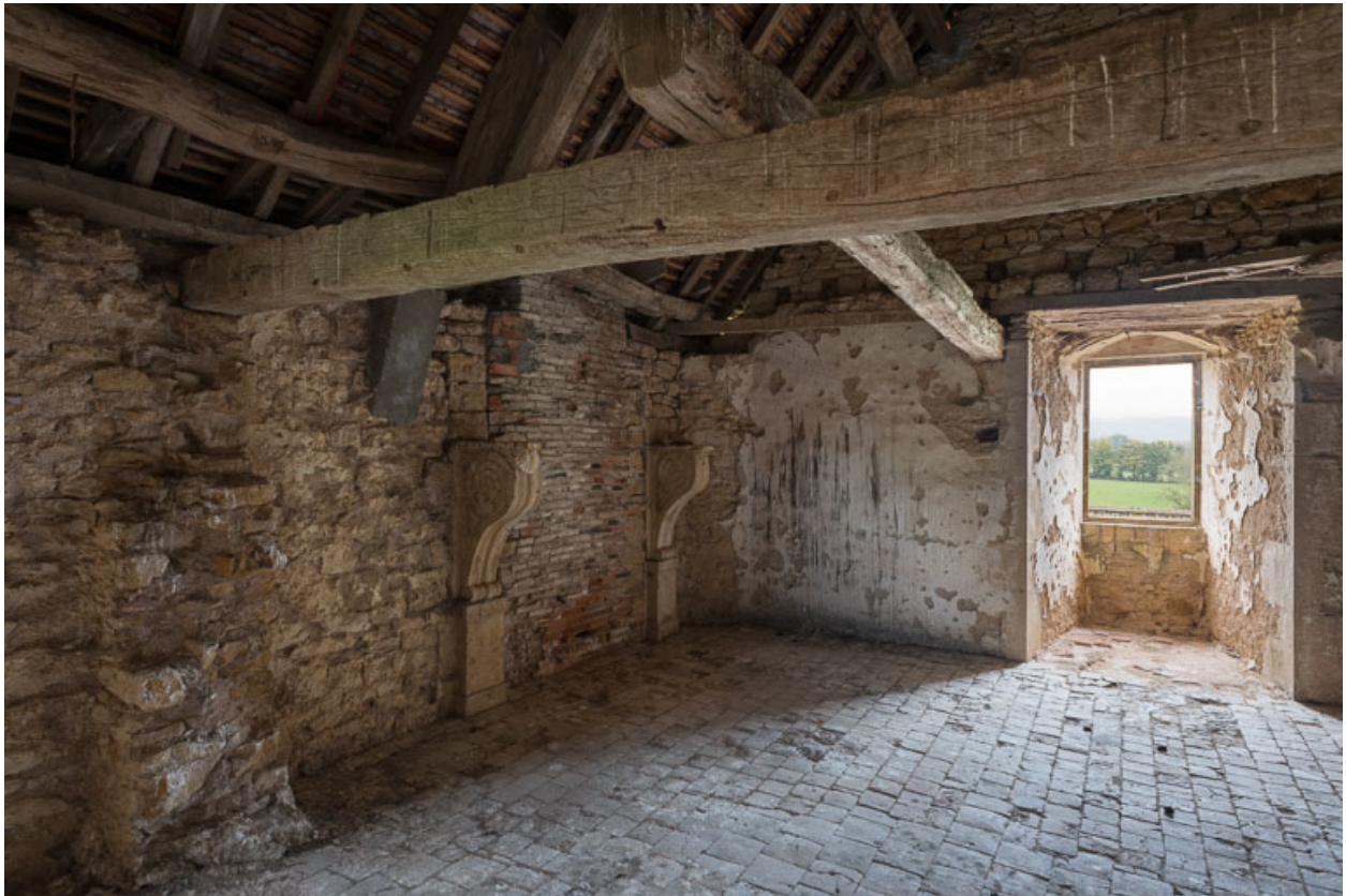
Vue du second étage de la tour, partiellement arasé
