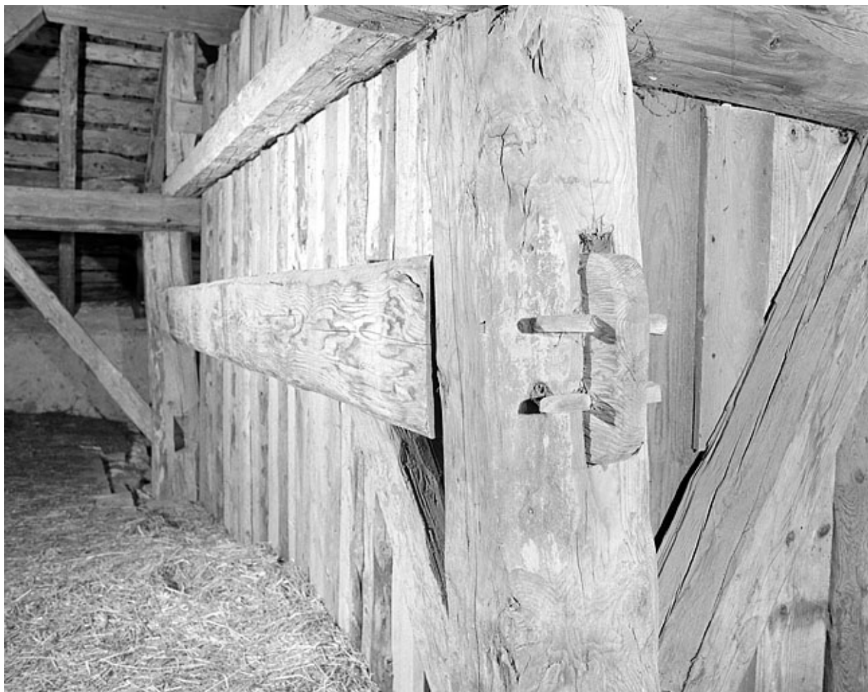
Assemblage de la charpente dans les combles.
