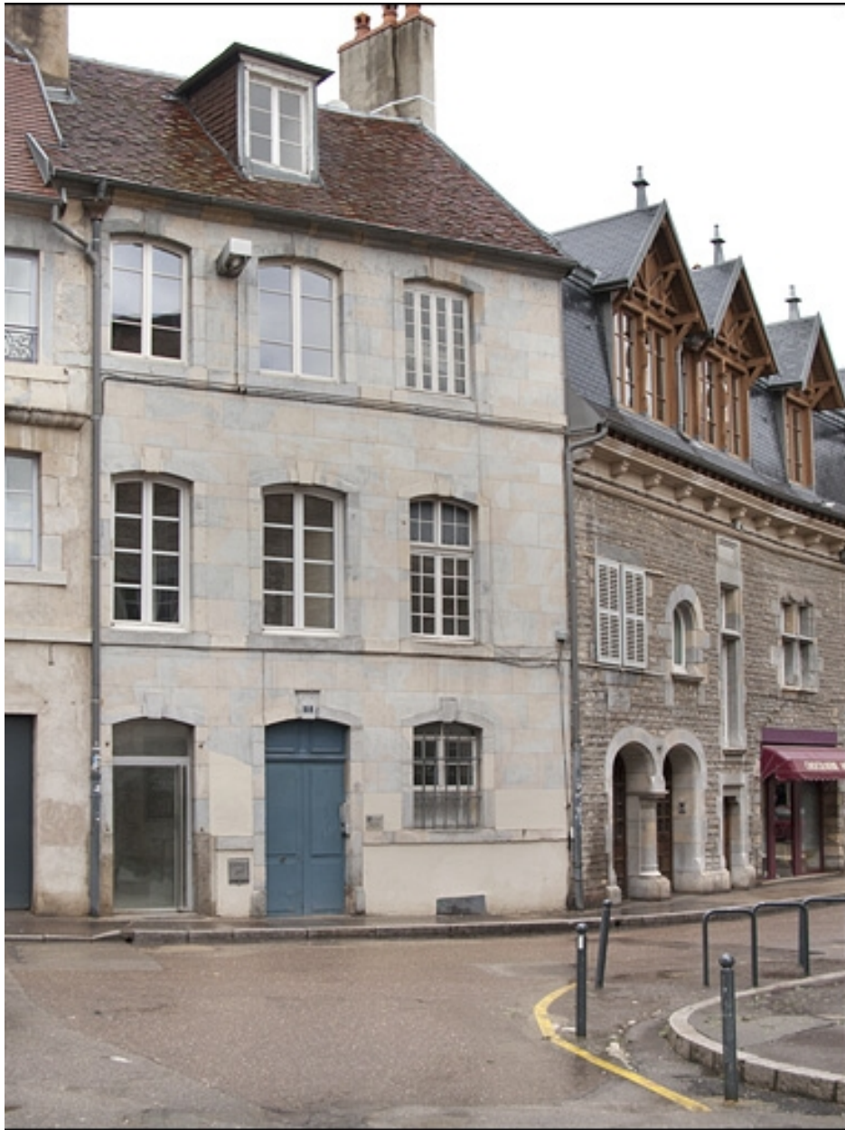
Vue d'ensemble de la façade donnant sur la rue Luc Breton.
