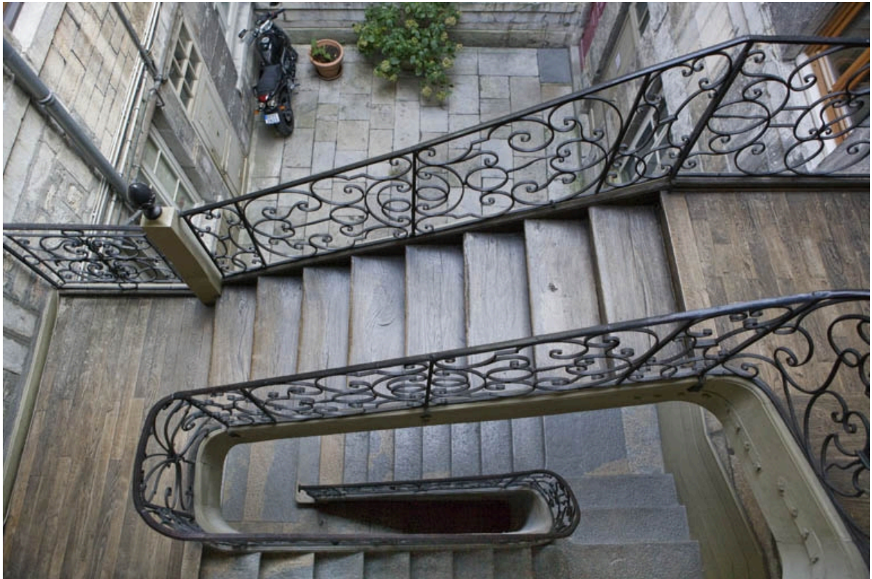
Vue en plongée de l'intérieur de l'escalier à cage ouverte.
