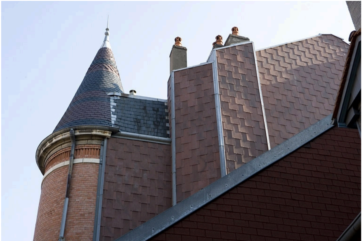
Détail de la partie supérieure de la tour d'escalier au niveau de la toiture du logis principal.
