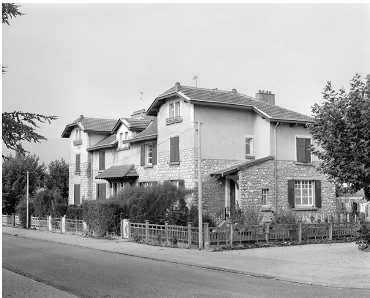
Façade antérieure et face droite.
