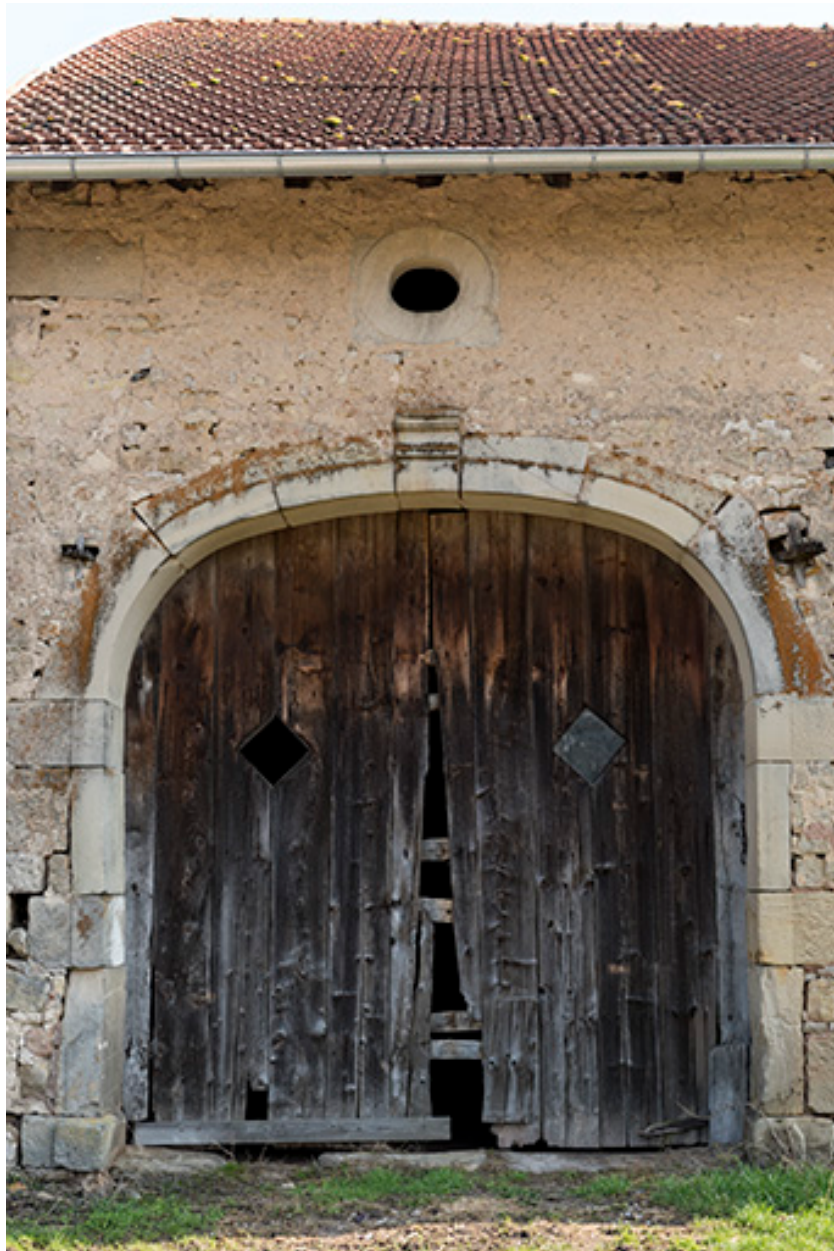
Alignement en bas du village, au nord de la fontaine. Détail de la porte charretière en anse de panier et de l'oculus ovale oblong.
