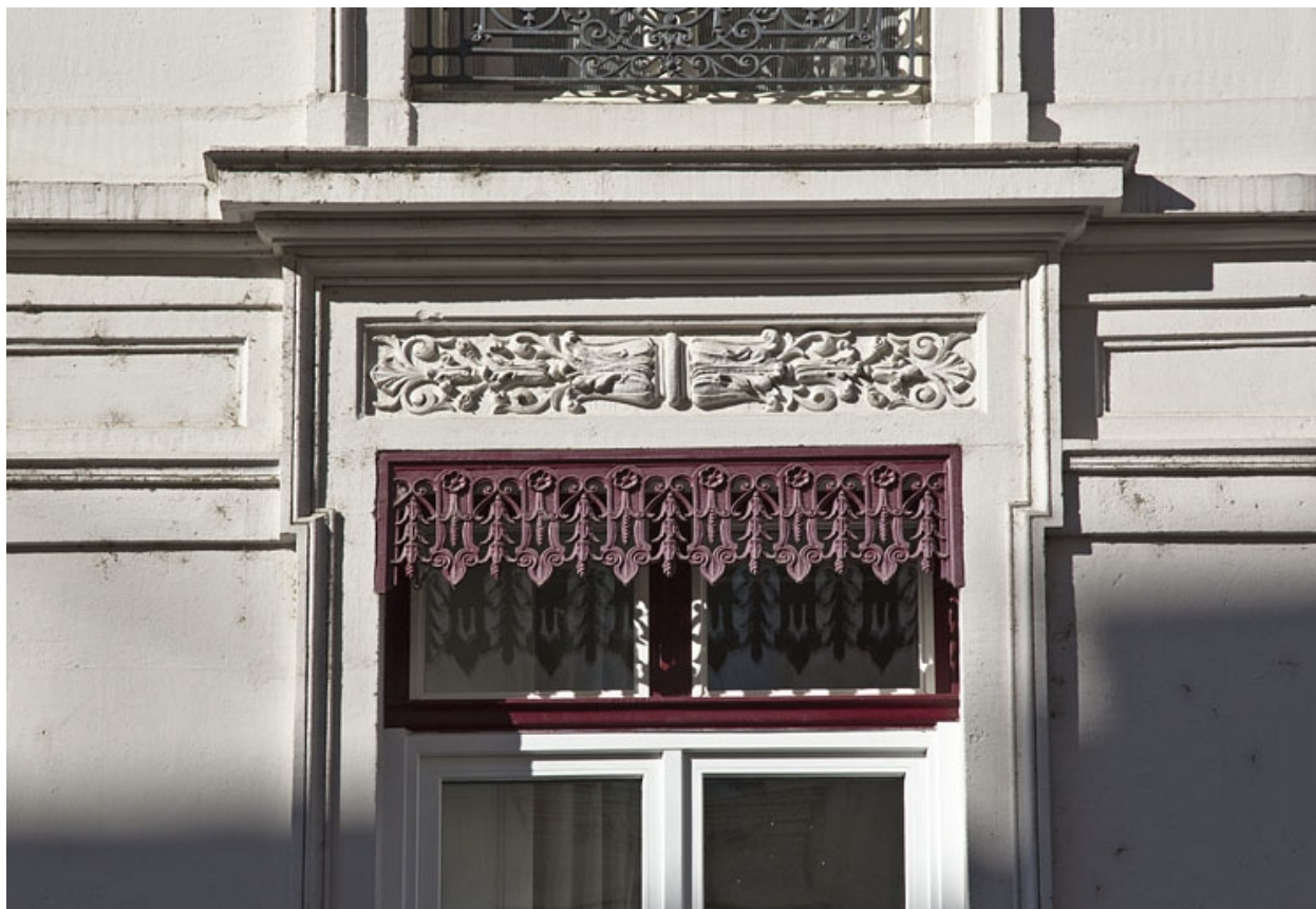
Façade antérieure : détail d'un linteau et du lambrequin de store d'une fenêtre.
