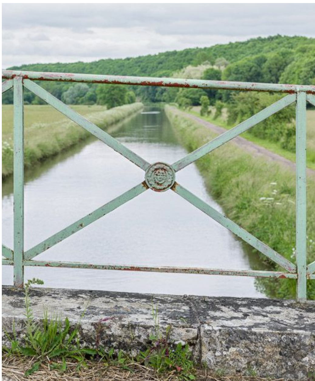
Détail du garde-corps.
