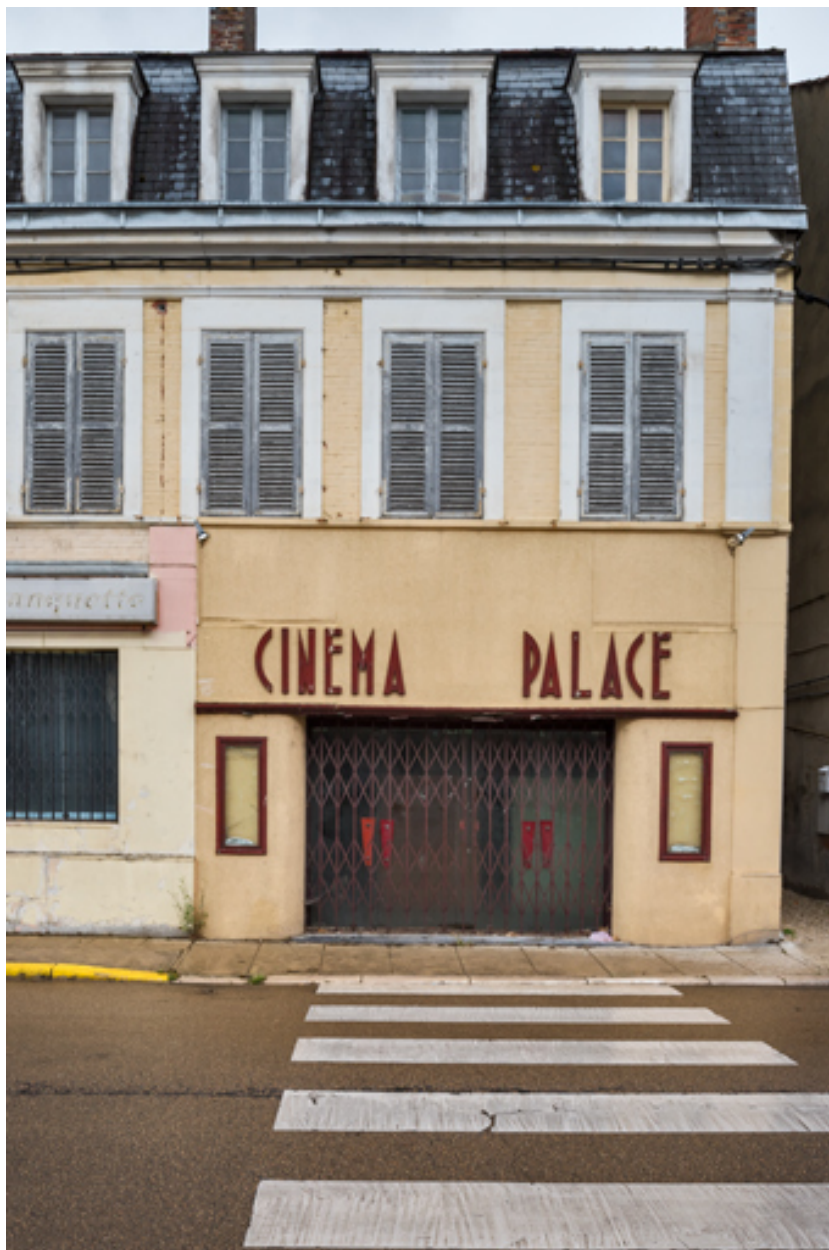
Saint-Florentin, 13 place Dilo : ancien cinéma Palace. Entrée.
