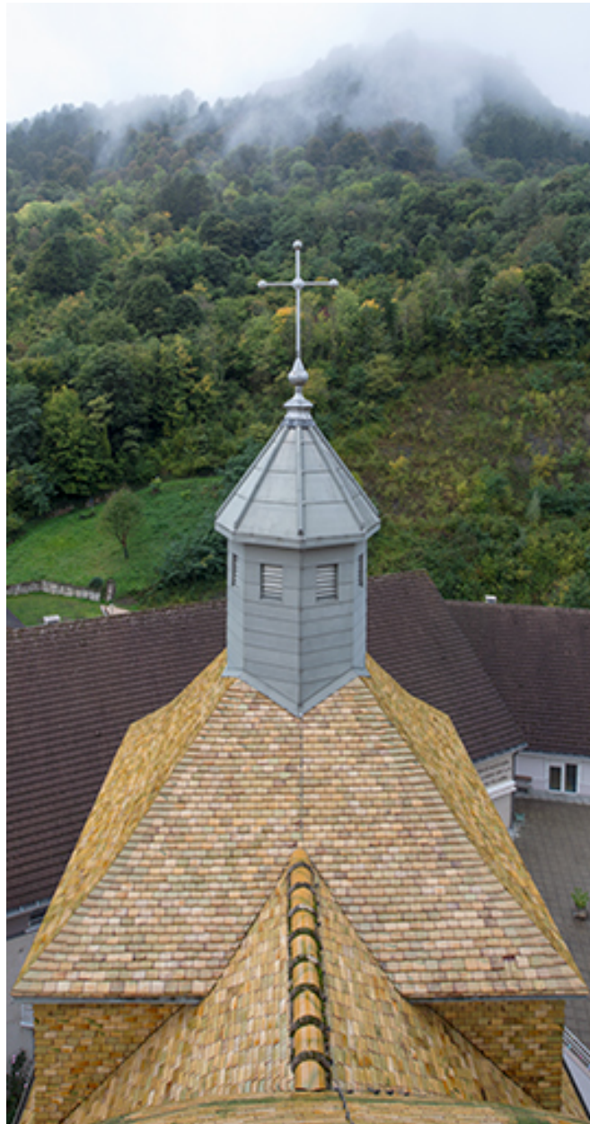
Toiture de la sacristie, depuis le lanterneau.
