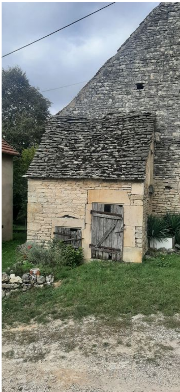
Vue de la construction depuis le sud.
