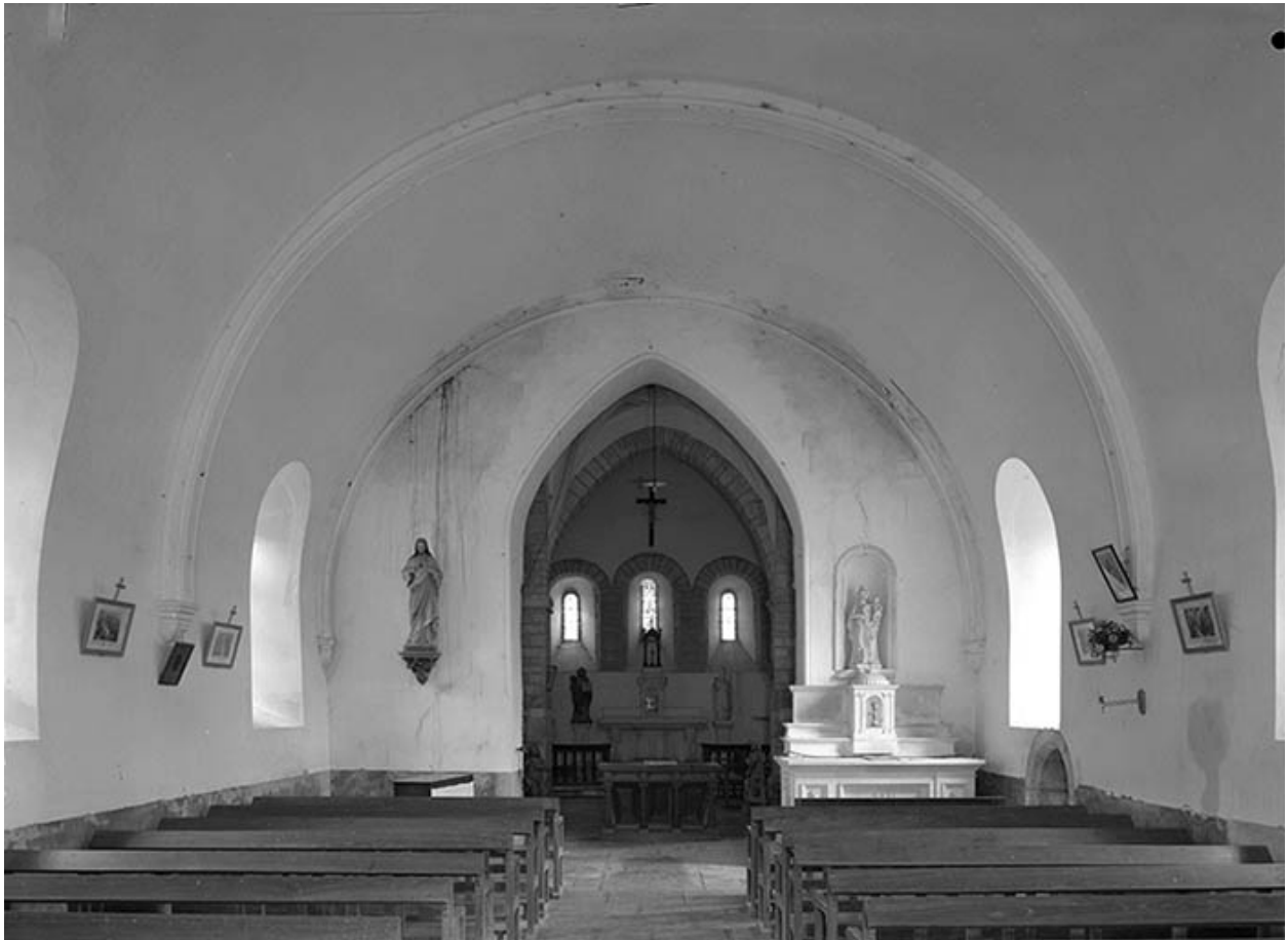
Vue intérieure vers le chœur.
